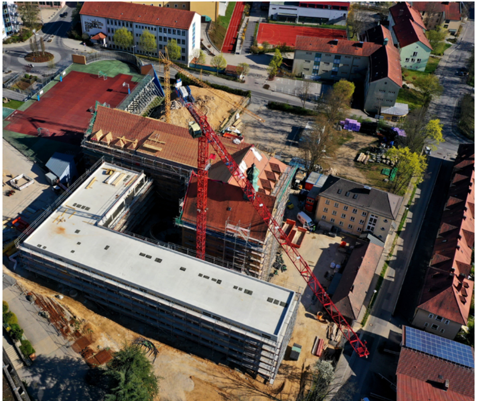
Fotos (Josef Kerscher): An der neuen gemeinsamen Marienrealschule in Cham wird auch während der Coronakrise fleißig weitergearbeitet.
